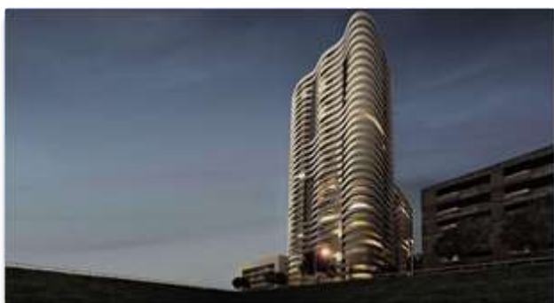
Proyecto futuro del edificio Lux ubicado en Lince, Lima.
