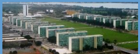
Esplanada dos Ministérios en Brasília, donde se construirán los nuevos edificios
